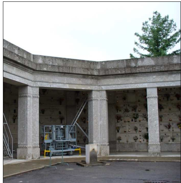
FIG.50 Portichetto di risvolto all'estremità orientale, di collegamento della fronte alla galleria 1948
