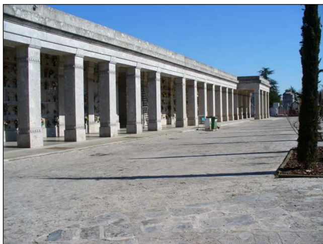
FIG.59 Gallerie di delimitazione del campo monumentale ovest
