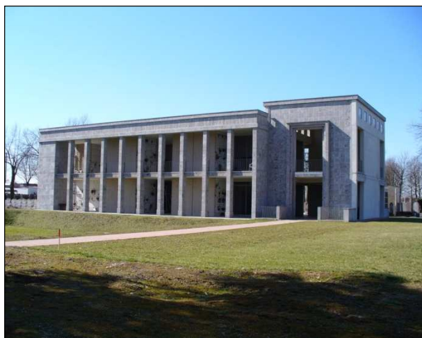
FIG.60 Nuova struttura destinata alle tumulazioni nella parte sud-ovest del cimitero
